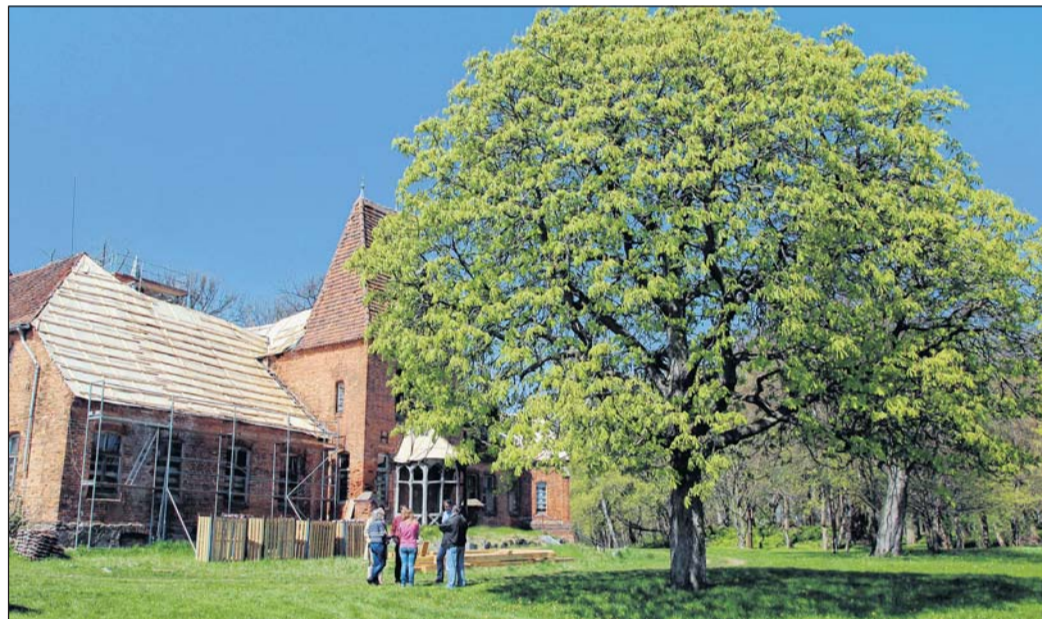
Hoffungsgrün: Im Frühling 2013 waren bereits erste Fortschritte bei der Sicherung des Pinnower Gutshauses zu sehen. Foto: S. Haerter
